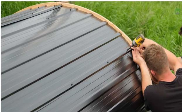
Fixer à l'aide de 5 vis autoscellantes pour toiture dans les crêtes supérieures et inférieures.
