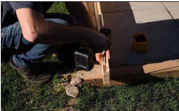
Vissez maintenant l'autre côté de la douelle supérieure à l'autre moitié de la douelle supérieure et elle doit maintenant former un "V" lorsqu'elle est calée avec la dernière douelle du sauna.
