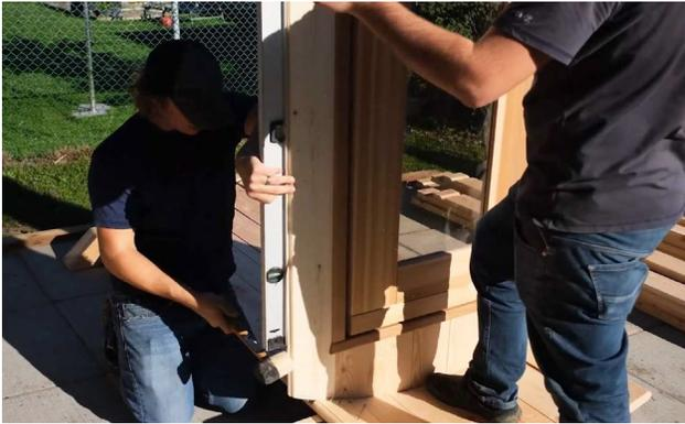
À l'aide d'un niveau et d'un maillet en caoutchouc, tapez sur la porte jusqu'à ce qu'elle soit centrée et de niveau.
