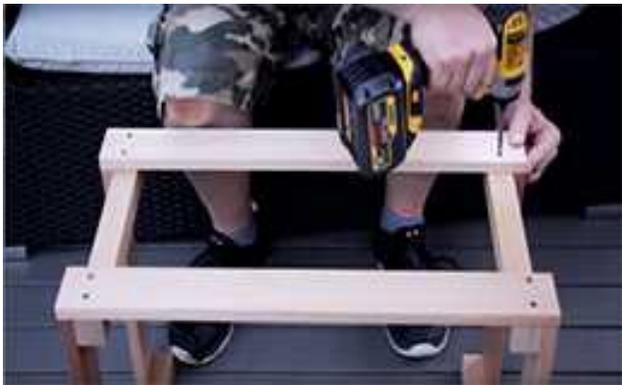
Visser le support de protection de l'appareil de chauffage de chaque côté à l'aide de (2) vis de 1 ½" (38 mm) par côté.
