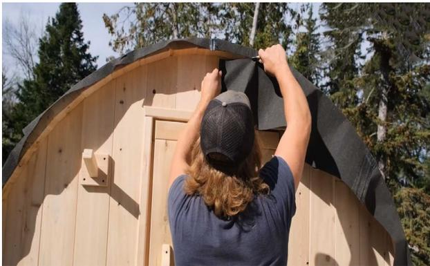
À l'aide d'un couteau utilitaire, coupez l'excédent de caoutchouc au ras du bord des douves à l'avant et à l'arrière du sauna.
