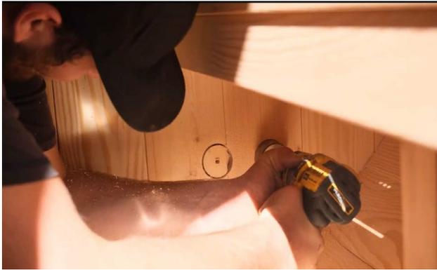
Percer à l'aide d'une scie cloche de 2" (51 mm).
