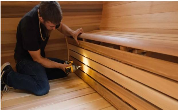
Fixez l'enceinte aux supports du banc à l'aide de vis de 2 ½" (64 mm).
