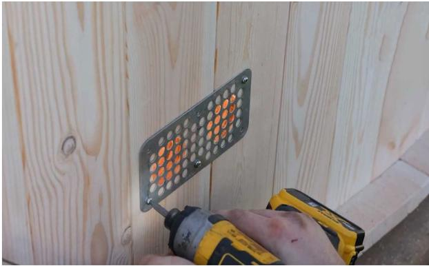
Répétez l'opération à l'extérieur du sauna pour les trous situés sous le poêle. Notez que ces trous n'ont pas de couvercle à l'intérieur.
