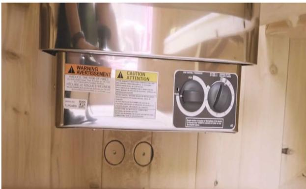
Pour installer le kit de ventilation du chauffage électrique, marquez et percez deux trous sous le chauffage électrique.
