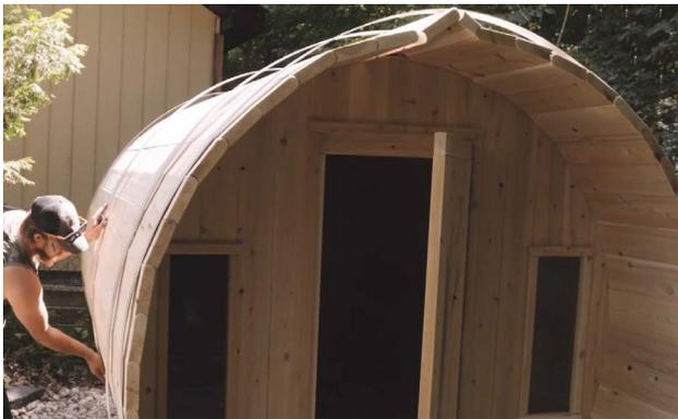
Pour la bande centrale, faites passer l'une des bandes par-dessus et par-dessous le sauna et fixez-la à l'aide d'une tige et d'un écrou.
