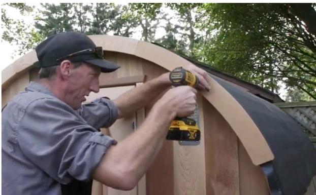
Ajoutez le morceau de garniture suivant en l'alignant sur le premier morceau et fixez-le à l'aide d'une vis de 2" (51 mm).
