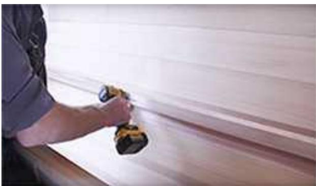
Mettre l'ensemble en place et le fixer aux parois et au sol du sauna à l'aide de 5 vis de 2 ½" (64 mm) sur les rails supérieurs et inférieurs.
