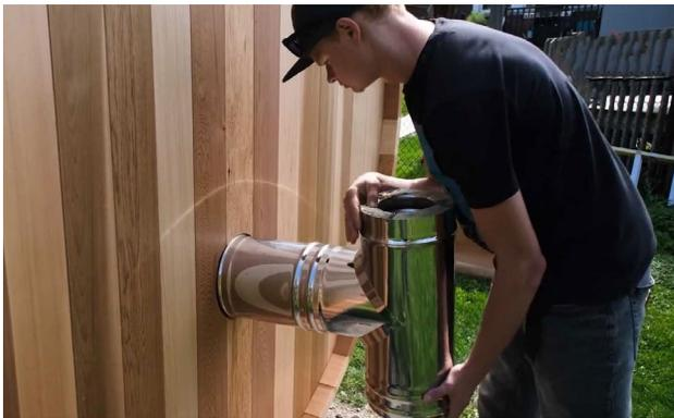
Insérer la cheminée en "T" dans le trou à l'arrière du sauna, à travers l'écran thermique de la paroi arrière à l'intérieur du sauna et à l'arrière du poêle.
