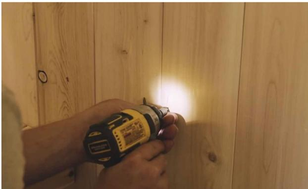
Installez les deux vis à tête hexagonale ¼" x 1 ½" (6mm x 38mm) (fournies avec le chauffage) dans les trous.
