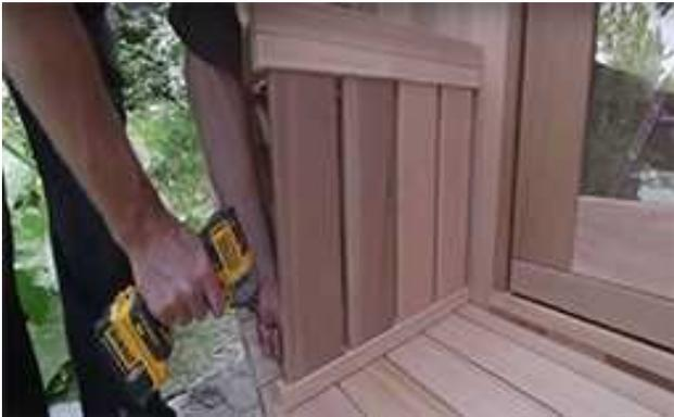
Fixer le banc au sol et à la paroi du sauna à l'aide de 3 vis de 2 ½" (64 mm) en haut et en bas.
