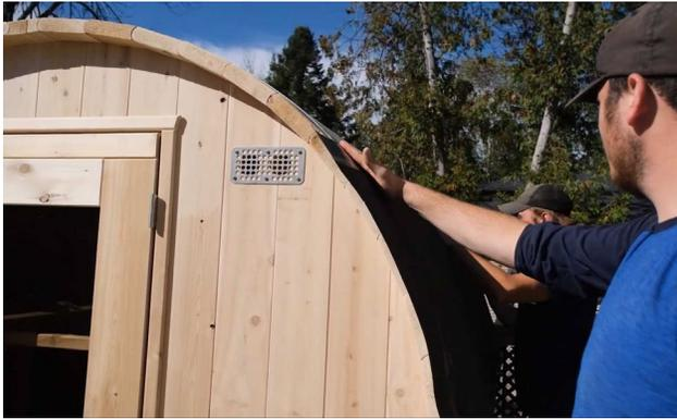
Pour commencer l'installation de votre toiture métallique, décollez la partie supérieure de l'écran de protection contre la glace et l'eau et collez-la sur le côté du sauna en commençant par le milieu d'un côté.
