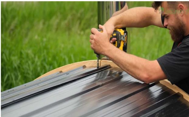
Fixez le centre des panneaux à l'aide de 8 vis à toiture auto-étanches.
