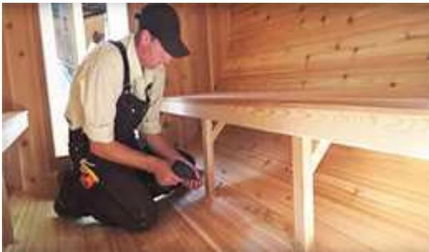
Fixer la jambe de force au sol à l'aide d'un Vis de 2 ½" (64mm) dans chaque support.
