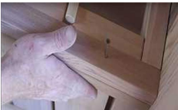
S'assurer que le banc est au même niveau que le support du banc et le fixer avec des vis de 2 ½" (64 mm) dans les trous du support. trous pré-percés.
