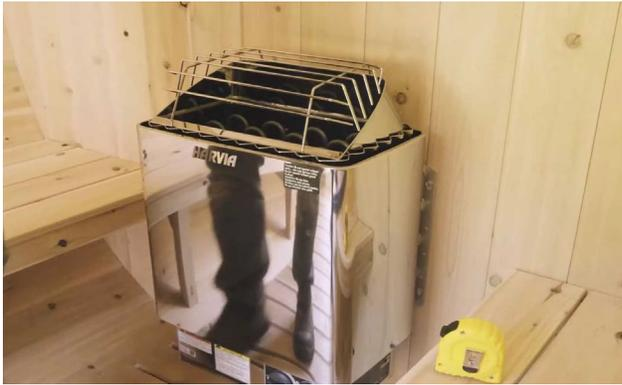
Accrocher le poêle sur les 2 vis et serrer pour fixer le poêle en position.
