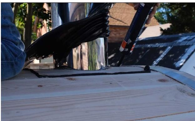
Soulevez le coffre pour le dégager et appliquez le produit d'étanchéité pour toiture fourni sur l'intérieur du contour.
