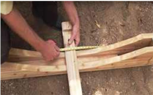
Centrez la douelle sur le berceau et mesurez 14 cm depuis l'extrémité de la douelle jusqu'au bord du berceau.
