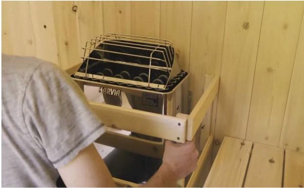
Centrez la protection autour de l'appareil et fixez-la au mur à l'aide des vis préinstallées.
