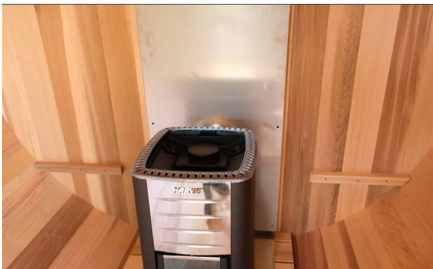
S'assurer que l'écran thermique de la paroi arrière est de niveau et le fixer avec 6 vis de 1 ½" (38 mm) à travers les trous percés.
