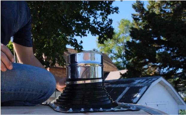
Placer le collier de serrage sur le soufflet et serrer la vis.
