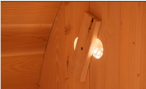
Utiliser une vis de 1 ½" (38 mm) et fixer le panneau de ventilation à l'intérieur du sauna en s'assurant qu'il est bien serré mais qu'il peut encore être tourné.
