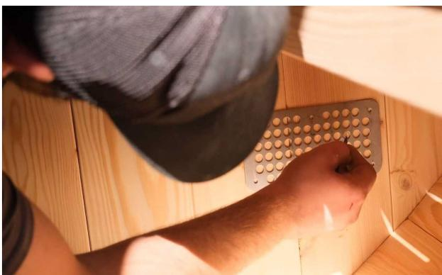
Sous le support du banc sur la paroi arrière, marquez la position du trou d'aération.
