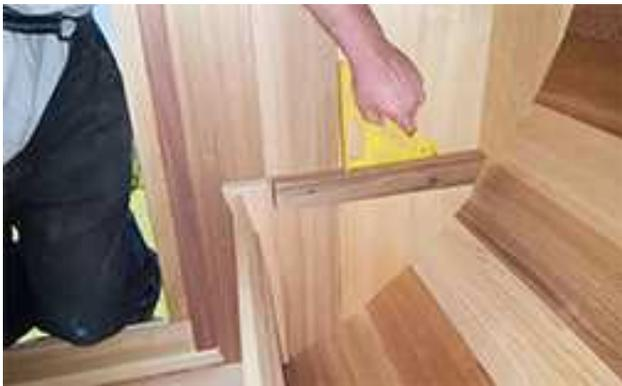
En utilisant l'enceinte avant comme guide, installer les supports muraux avec 3 vis de 2 ½" (64 mm), en s'assurant à nouveau qu'ils sont au même niveau que les murs ou la porte du sauna et qu'ils affleurent le haut de l'enceinte avant.
