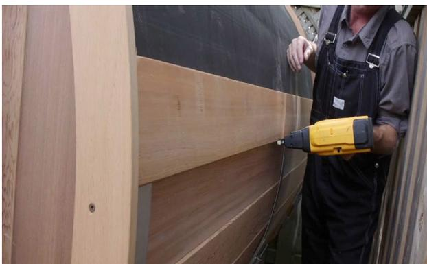
Fixez le bardage en biseau au sauna à l'aide d'un pistolet à agrafes et d'agrafes à couronne de 1 ¼" (32 mm).
