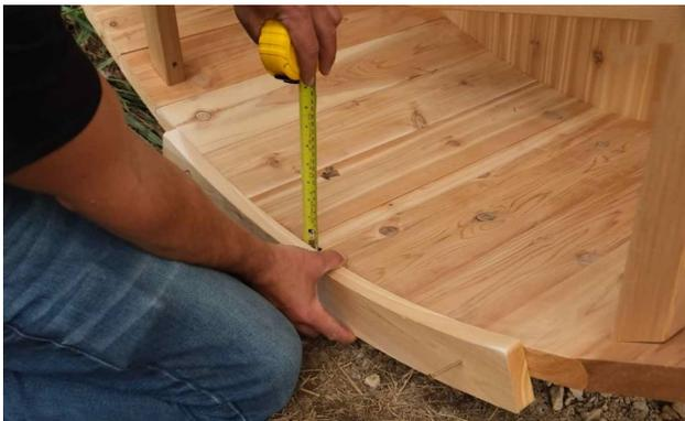
Centrer l'une des pièces de garniture du bas sur l'avant du sauna. La soulever de ½" (13mm) et la fixer avec 3 vis de 1 ½" (38mm).
