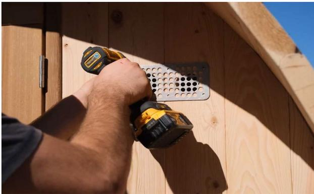
En haut de la paroi avant, répétez ce processus et montez le couvercle de ventilation à l'extérieur du sauna.
