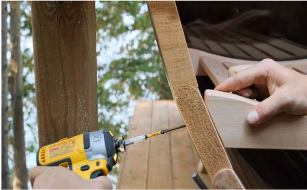
Utilisez une vis de 2 ½" (64 mm) pour fixer l'avant et l'arrière du siège de la véranda, en vissant à travers le dossier latéral dans les supports du siège.
