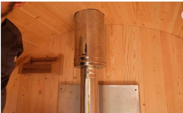
Placez le premier tuyau de cheminée isolé et épais sur le premier tuyau et faites-le passer par le trou dans le toit.
