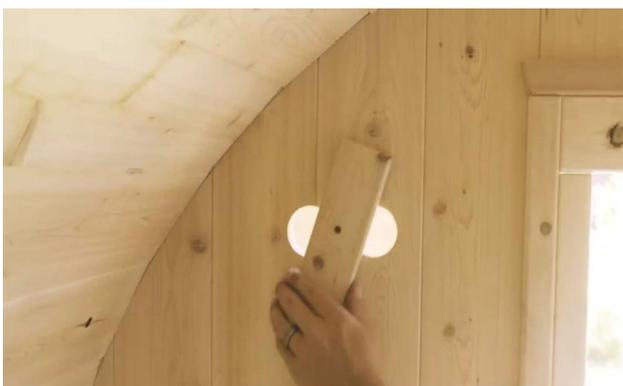
Installer le couvercle de ventilation à l'intérieur du sauna à l'aide d'une vis de 1 - 1 ½" (38 mm) centrée entre les trous.
