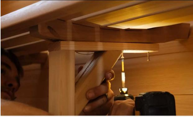
Placez les supports de banc sous les supports de siège et fixez-les avec 3 vis de 1 ½" (38 mm).
