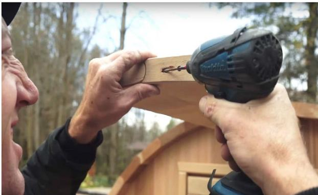
Fixez chaque pièce de la corniche à la suivante par les trous pré-perçés sur l'avant de chaque pièce à l'aide d'une vis de 2 ½" (64 mm).
