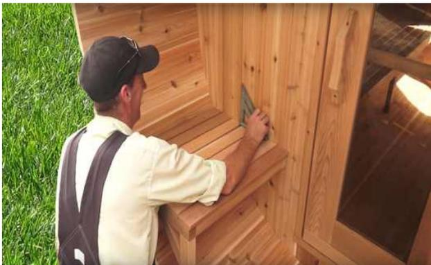
Utilisez un niveau ou une équerre de charpentier pour vous assurer que le siège de la véranda est de niveau.
