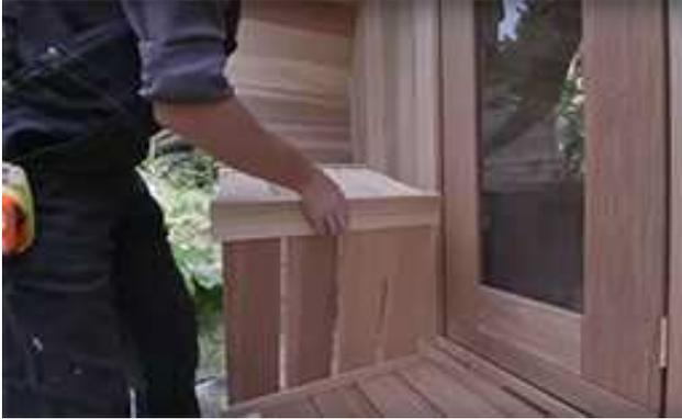
Assemblez le siège et l'enceinte avant à l'aide de vis de 2 ½" (64 mm).
