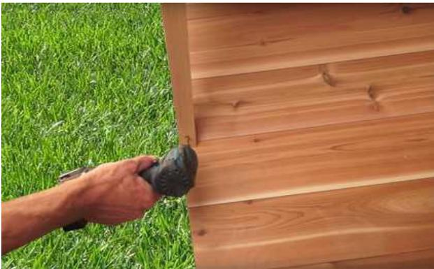
Fixez le pied au sol à l'aide d'une vis de 2 ½" (64 mm).
