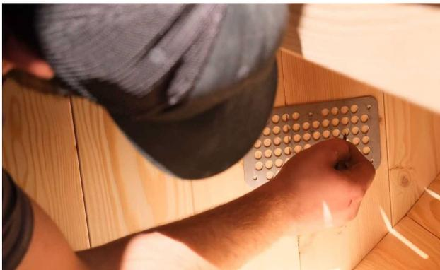
Sous le support du banc sur la paroi arrière, marquez la position du trou d'aération.
