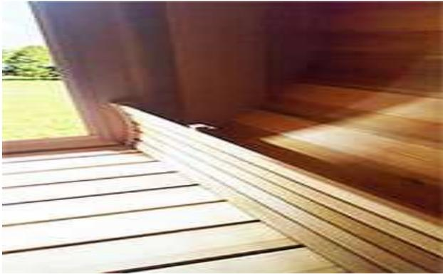
Pour commencer l'installation des bancs signature, positionnez la paroi avant au bord du sol plat pour déterminer la hauteur du support de siège.
