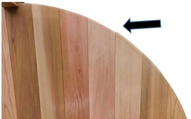
Centrer les panneaux en demi-lune verticalement sur le mur central et les fixer en place.
