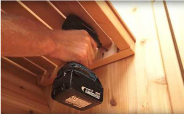
Fixez le siège de la véranda à la paroi avant par le dessous à l'aide de (3) vis de 2 ½" (64 mm).
