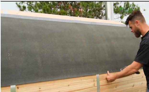
Retirer la moitié inférieure de l'écran de protection contre la glace et l'eau, la coller au sauna et la fixer au sauna à l'aide d'agrafes en travers de la partie inférieure.
