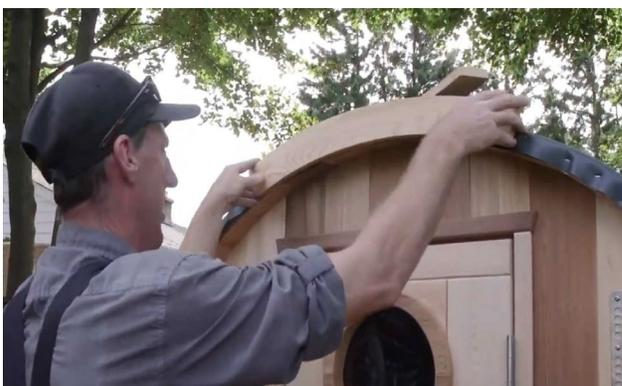
Centrez l'une des pièces de garniture au sommet du sauna en l'alignant sur le bord inférieur des douves.
