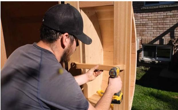
Installez la poignée intérieure de la porte (grande) horizontalement à la hauteur souhaitée. Assurez-vous que la poignée est de niveau et fixez-la à l'aide de vis de 2 à 3" (76 mm) dans les trous pré-perçés.
