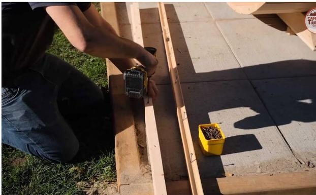
La douelle supérieure étant en deux parties, fixer la douelle d'écartement à la moitié de la douelle supérieure sans les vis à l'aide de vis de 2" (51 mm).
