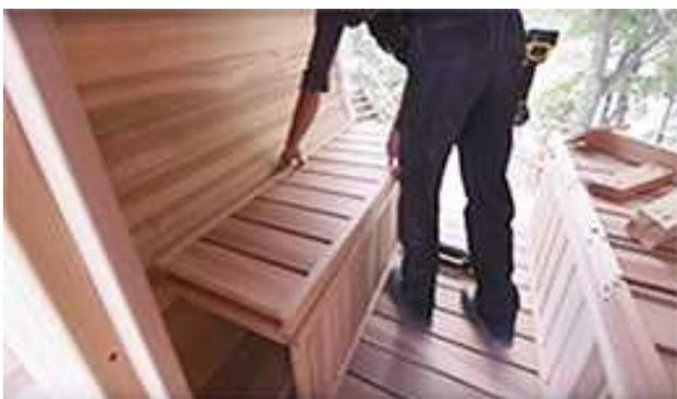
Veillez à ce que le banc soit affleurant et fixez-le à l'aide de vis de 64 mm (2 ½") entre les planches du siège, de manière à ce que les vis soient moins visibles.
