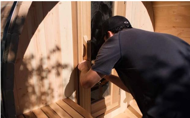
Installez la poignée extérieure de la porte (petite) à la hauteur souhaitée en utilisant des vis de 2 - 3" (76 mm) dans les trous pré-perçés.
