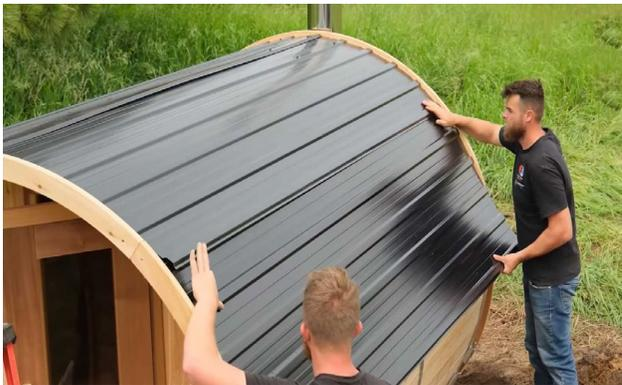
Placez le panneau suivant et assurez-vous que l'arête inférieure du panneau précédent recouvre l'arête supérieure du panneau inférieur.
