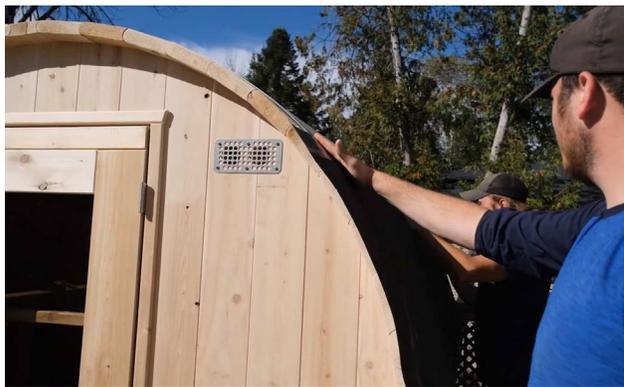
Pour commencer l'installation de votre toiture en biseau, détachez l'écran de protection contre la glace et l'eau et collez-le sur le côté du sauna en commençant par le milieu d'un côté.
