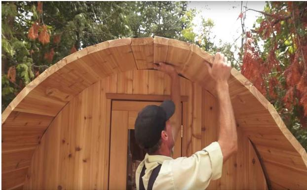
Utilisez le maillet en caoutchouc pour frapper les douelles vers l'extérieur et vers l'intérieur si nécessaire pour que la dernière douelle murale et la douelle supérieure s'emboîtent correctement.
