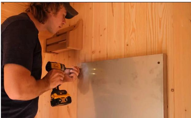
Placez l'écran thermique de la paroi arrière et fixez-le avec 6 vis de 1 ½" (38 mm) dans les trous percés.
