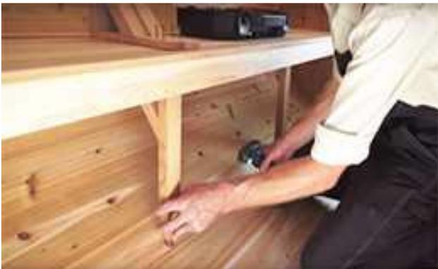
Espacer les supports des bancs sous les traverses de la partie inférieure des bancs.
