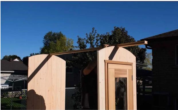
Utilisez la douelle supérieure (concave de chaque côté) pour aller de la paroi avant à la paroi arrière afin d'aider à stabiliser le sauna.
