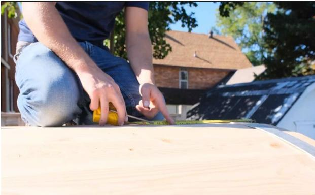
Sur le dessus du sauna, mesurez 305 mm (12") à partir de l'extrémité des douelles.
