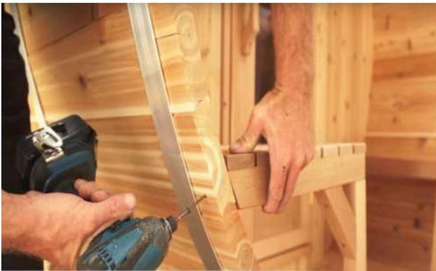
Vissez l'avant du siège de véranda dans le mur depuis l'extérieur à l'aide d'une vis de 2 ½" (64 mm).
