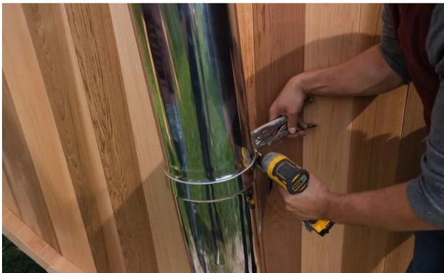
Attachez une sangle de soutien autour de la connexion et serrez.
