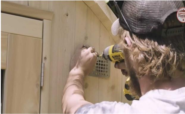
Fixez le couvercle de ventilation en acier inoxydable sur les trous situés à l'avant du sauna à l'aide des vis fournies.
