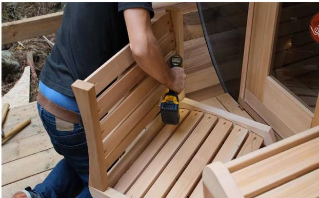
Retournez le siège de la véranda et fixez l'enceinte de la véranda avant au siège en veillant à ce que le contour soit orienté dans le bon sens à l'aide de vis de 2 ½" (64 mm) dans les trous prépercés.
