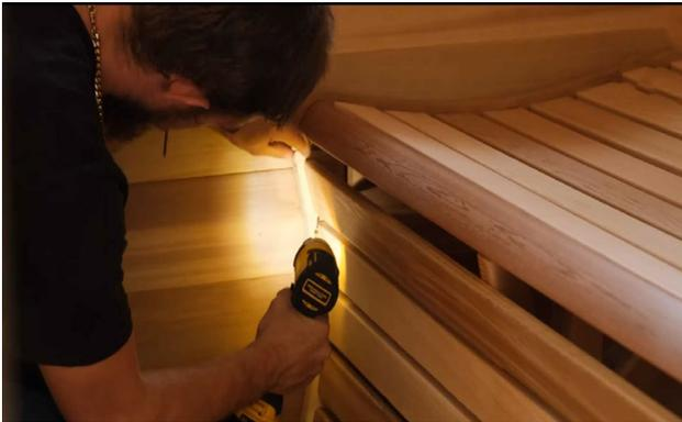
Fixez le boîtier avant au mur et aux supports du banc à l'aide de vis de 2 ½" (64 mm).
