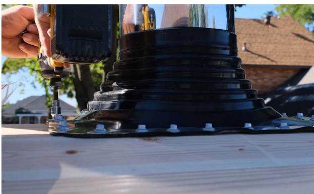
Tirez la botte vers le bas et fixez-la à l'aide des vis de couverture auto-étanches incluses, espacées de 2 à 3 pouces (51 mm à 76 mm).
