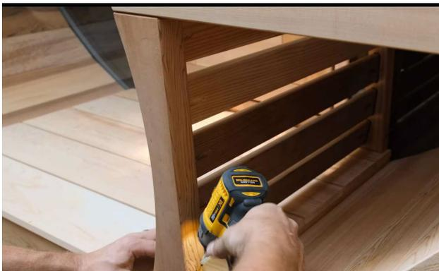
Fixer au sol et au mur sous le siège à l'aide de vis de 2 ½" (64mm).
