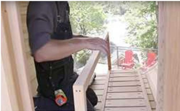
En utilisant les trous prépercés, assemblez le support du banc de salon à la paroi inférieure du banc, plus longue, à l'aide de vis de 2" (51 mm).
