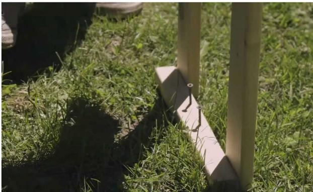
Placer 2 vis de 2 ½" (64 mm) dans les trous pré-perçés de chaque côté de la protection du chauffage pour préparer le montage.
