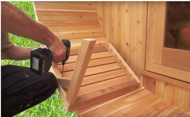
Pour installer les sièges de porche standard, vissez les pieds à l'extrémité des sièges avec des vis de 2 ½ " (64 mm).
