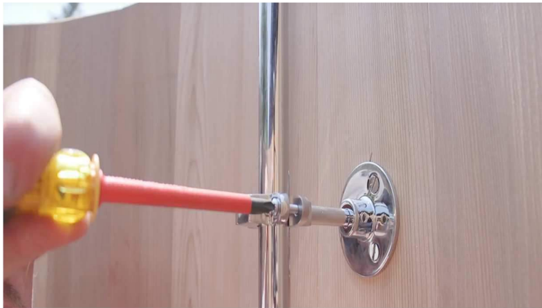
36. Serrez le support fermement pour vous assurer que le pommeau de douche fait face vers l'avant.
