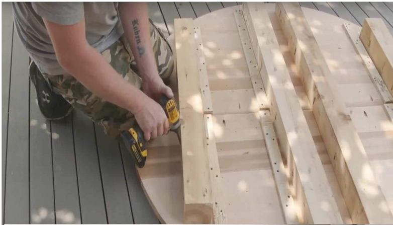
7. Fixez bien les supports de bois à l'aide de vis de 2 1/2po.
