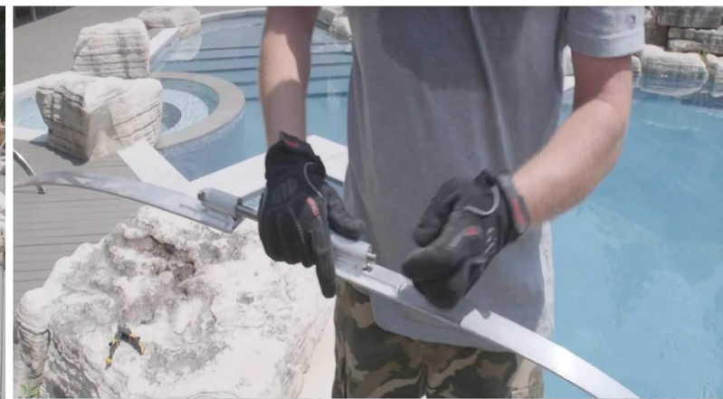
22. Amenez les bouts ensemble sur la première bande et connectez-les à l'aide de la tige filetée et des écrous comme montré.
