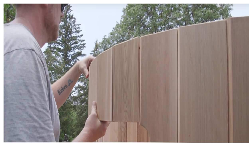
19. Faites entrer la pièce supérieure d'entrée.
