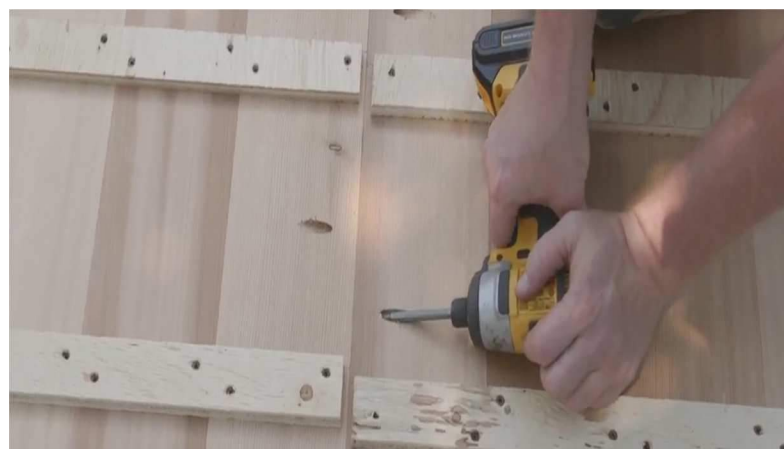
5. Vissez ensemble à l'aide des vis de 2 1/2 po.
