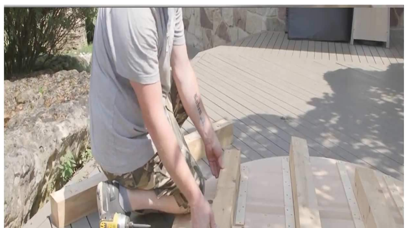
6. Placez les supports de bois dans les pièces de plancher, les morceaux plus longs à l'intérieur et les morceaux plus courts à l'intérieur. Assurez-vous que les supports de bois sont centrés et ne couvrent pas la partie extérieure.
