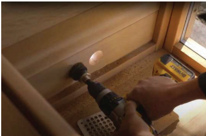
Trous d'entrée percés sous le chauffage électrique sur la paroi latérale
