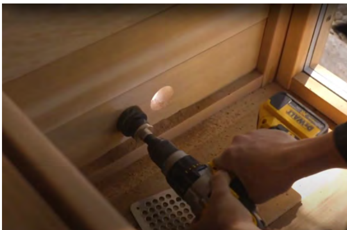
Trous d'entrée percés sous le radiateur électrique sur la paroi latérale
