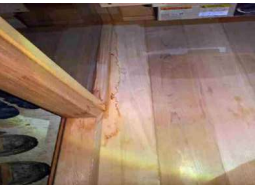
Infiltration d'eau
